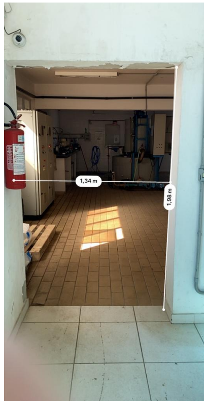
Figura 2: Porta de entrada da sala de dosagem
